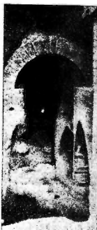
Abertura subterránea de uno de los tubos que iban de la gruta a una de las estatuas huecas de arriba.
