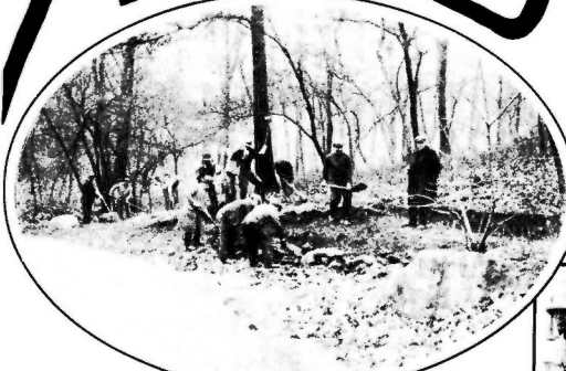
NEW YORK, Estados Unidos. —Los sin trabajo que con un jornal de 5 pesos al día han sido contratados por el Comité de Auxilio que preside Prosser, aparecen aquí trabajando en las obras de reparación de los caminos, cerca de esta ciudad. Así resuelven los norteamericanos el problema de los desocupados.
